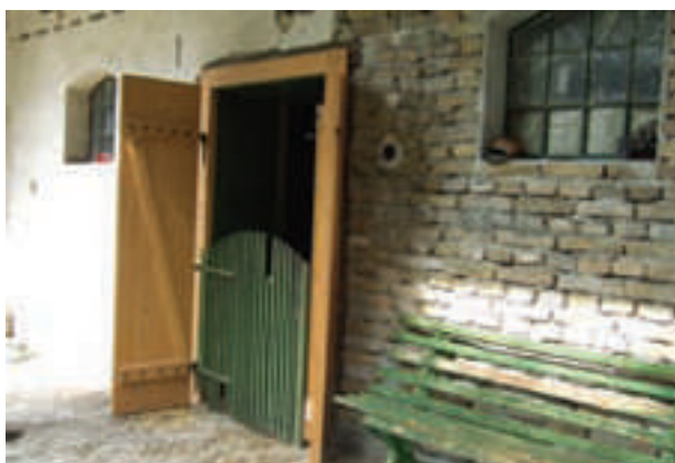
Сл. 22 Улаз у шталу (фото П. П. Ј., 2014) Fig. 22 Entrance to the barn (photo P. P. J., 2014)
