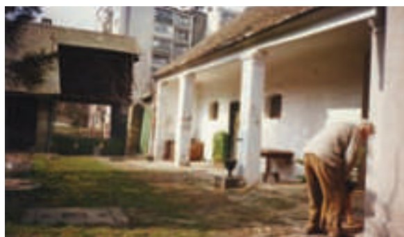
Сл. 21а Дворишна фасада помоћне зграде (фото П. П. Ј., 2014) Fig. 21a Courtyard facade of a spare building, previous condition (photo P. P. J., 2014)
