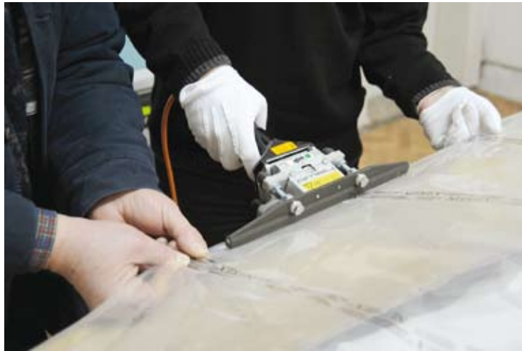
Сл. 26 Спајање контејнера
