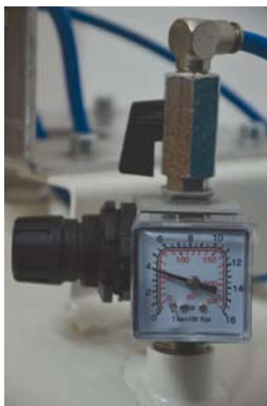
Сл. 12 Излазни вентил за контролу протока Fig. 12 Outlet valve for flow control
