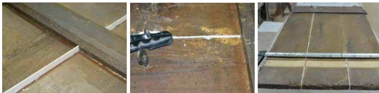
Сл. 14–16 Уметање и нивелисање летвица Fig. 14–16 Inserting slates and fixing them
