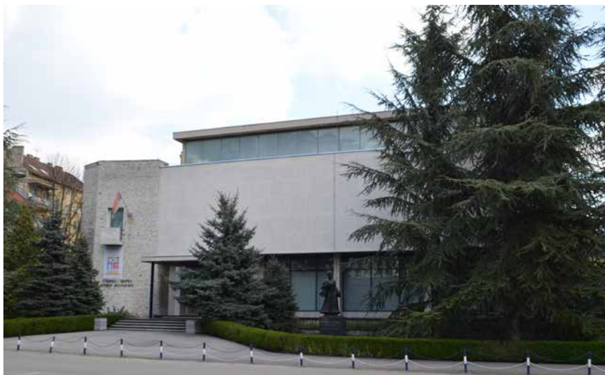
Сл.1 Спомен-збирка Павла Бељанског (фото: СЗПБ)
