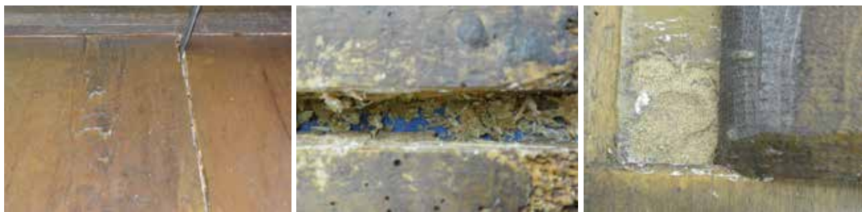
Сл. 11–13 Раздвајање и чишћење дасака Fig. 11–13 Dismantling and cleaning the boards
