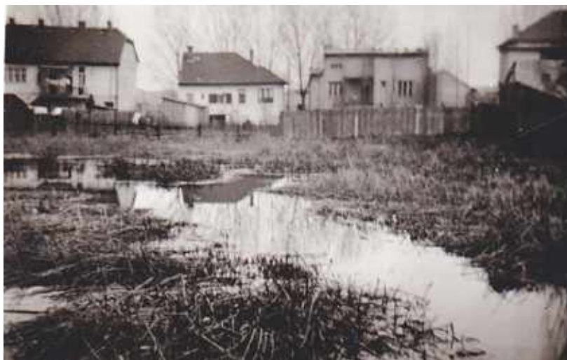
Сл. 10 Подземне воде честа појава на лиманима
